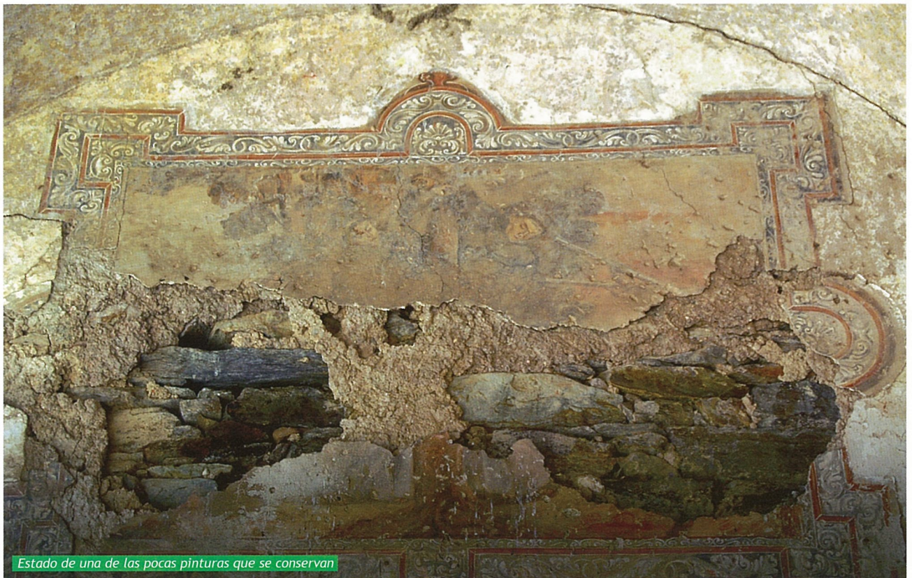
Vista de los elementos destruidos o desaparecidos en el interior de la iglesia
