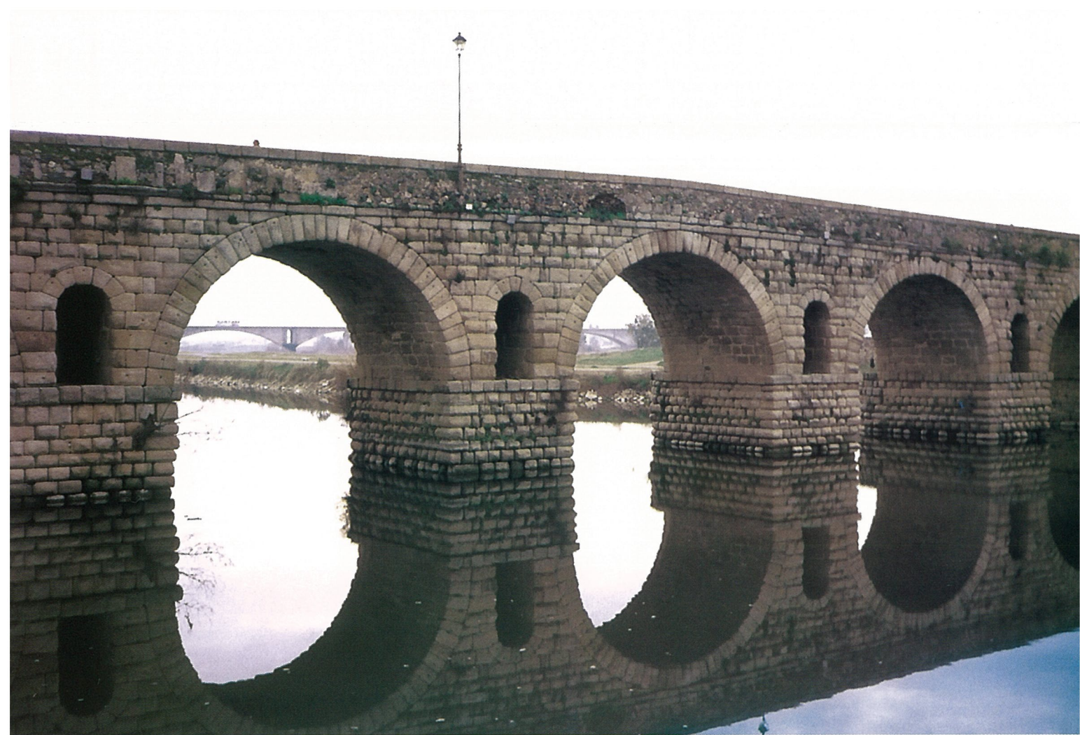
Puente Romano sobre el río Guadiana. Mérida.
