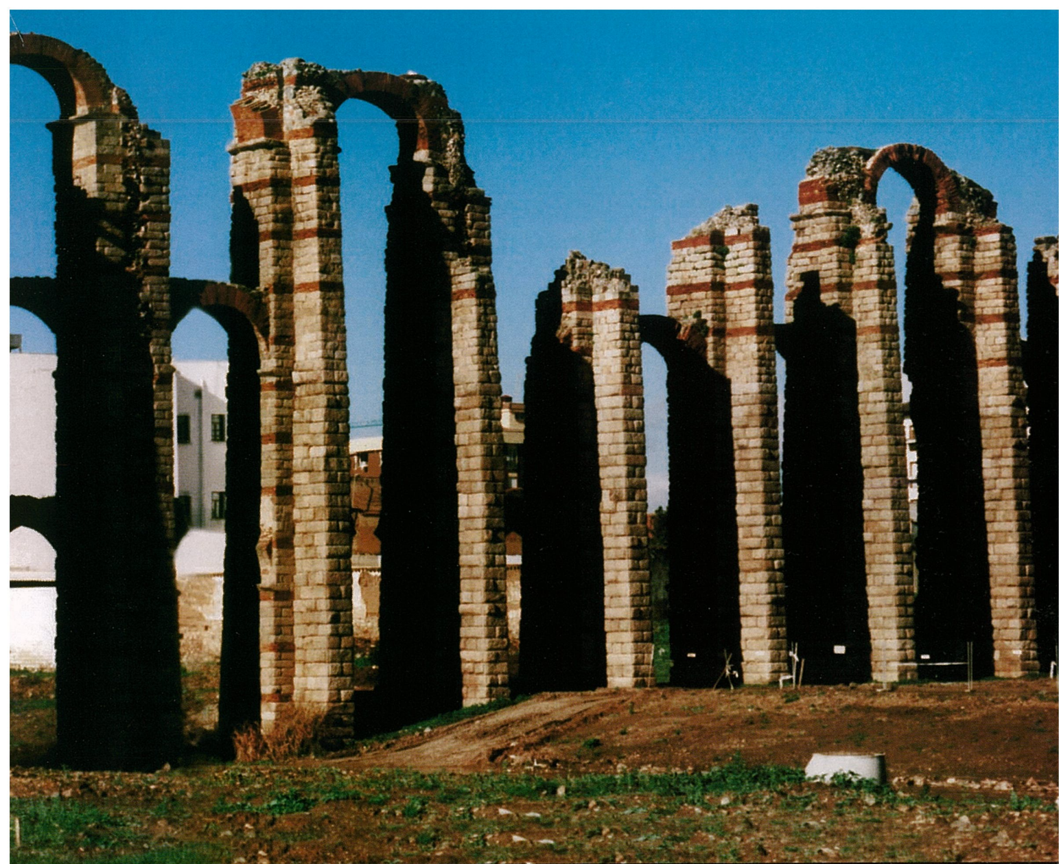
Acueducto de Los Milagros
